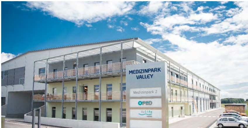
2018: Inbetriebnahme der 5.500m 2 großen Produktions- und Lagerhalle © OPED GmbH
